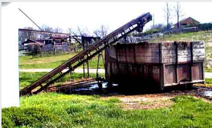
Obr. č. 56: Vynášecí dopravník chlěvské mrvy
