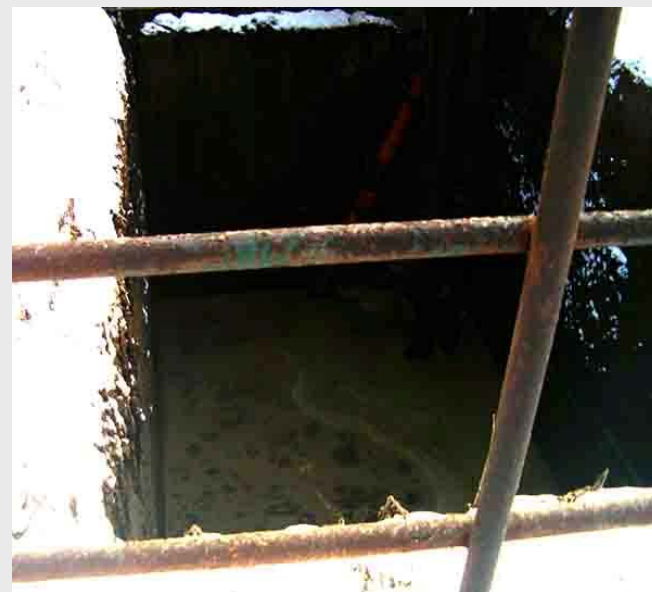
Obr. č. 61: Betonová podzemní jímka na výkaly
