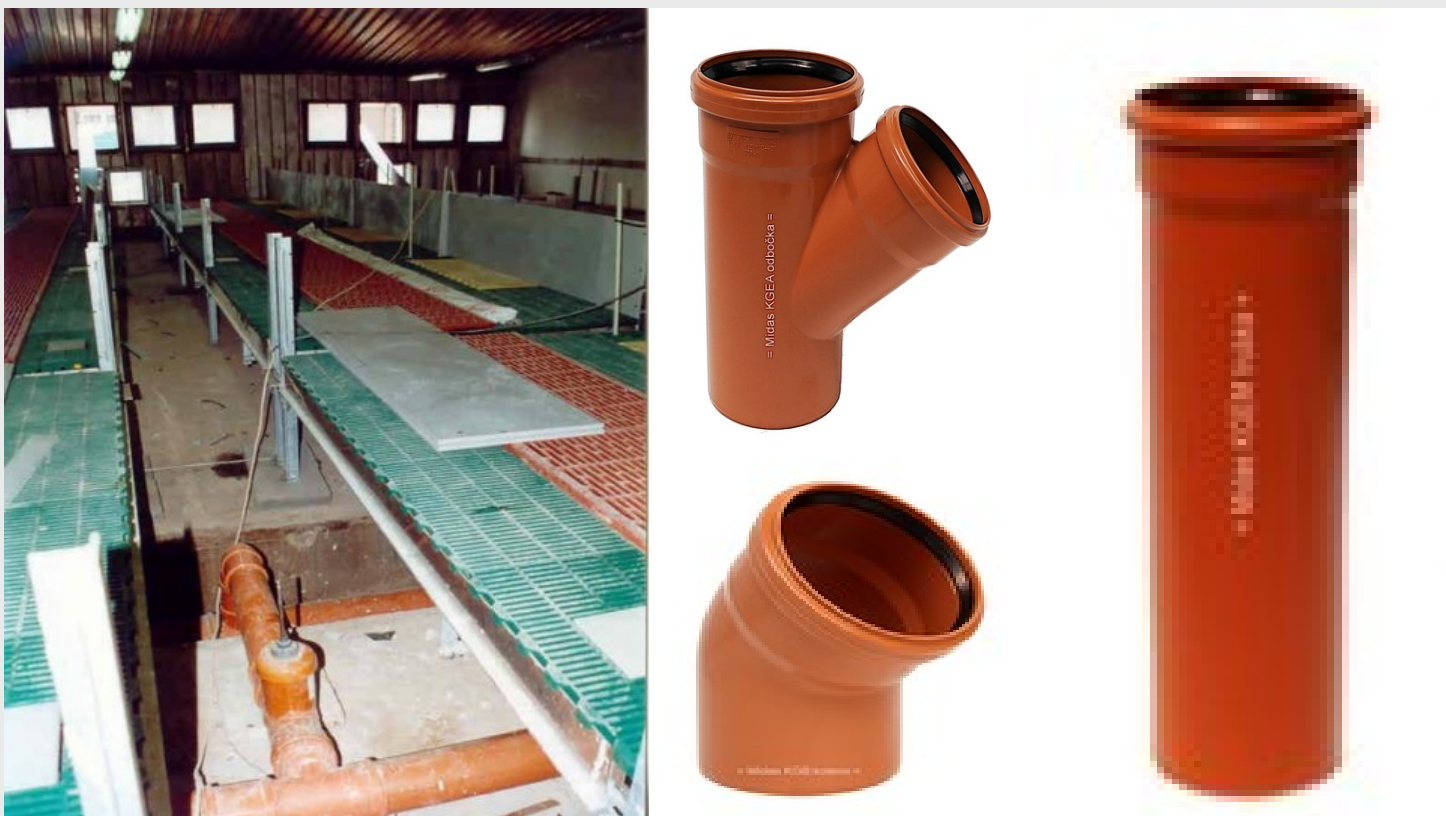
Obr. 35 : Ukázka vedení tekutých výkalů v plastovém potrubí ( http://www.agrico.cz )
