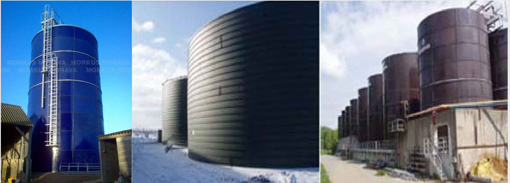
Obr. 31 : Nádrže na tekuté výkaly http://www.morkus-morava.cz
