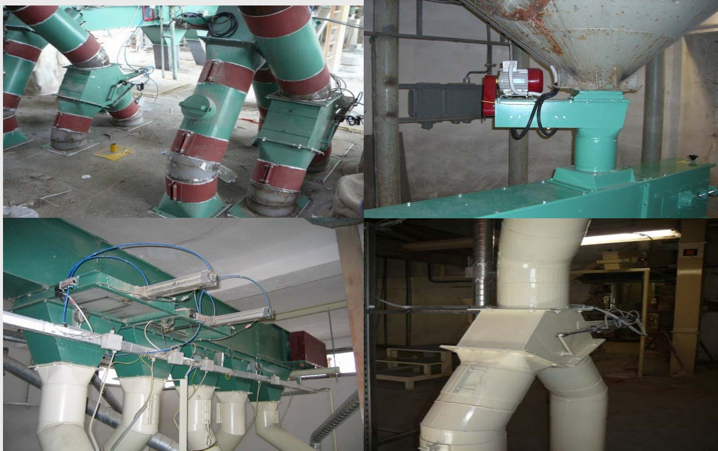
Obr. č. 2: Prvky spádové dopravy
