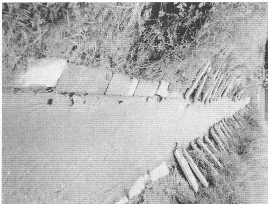
Ukázka revitalizace kanalizovaného Mlýnského potoka na k. ú. Pasčíná (okr. Český Krumlov) v roce 1998. Vlevo stav před revitalizací, vpravo stav po odstranění pame- la z koryta, zpevnění břehu kameny, výbudování kamenných přehrážek a výsadba doprovodné zeleně.
