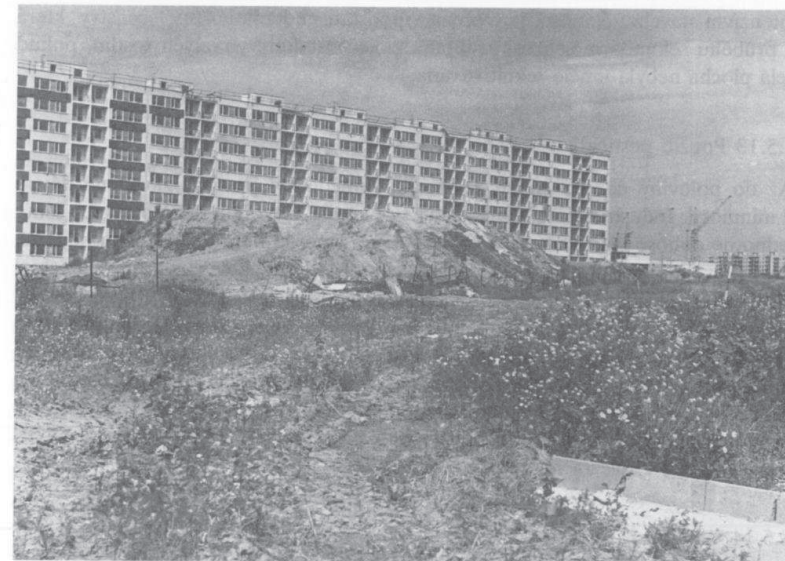
Obr. 111. Zánik původního půdního povrchu a porušení půdního profilu při stavebních pracích (foto J. Moravec).
