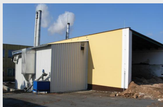
8. Teplárna na biomasu
