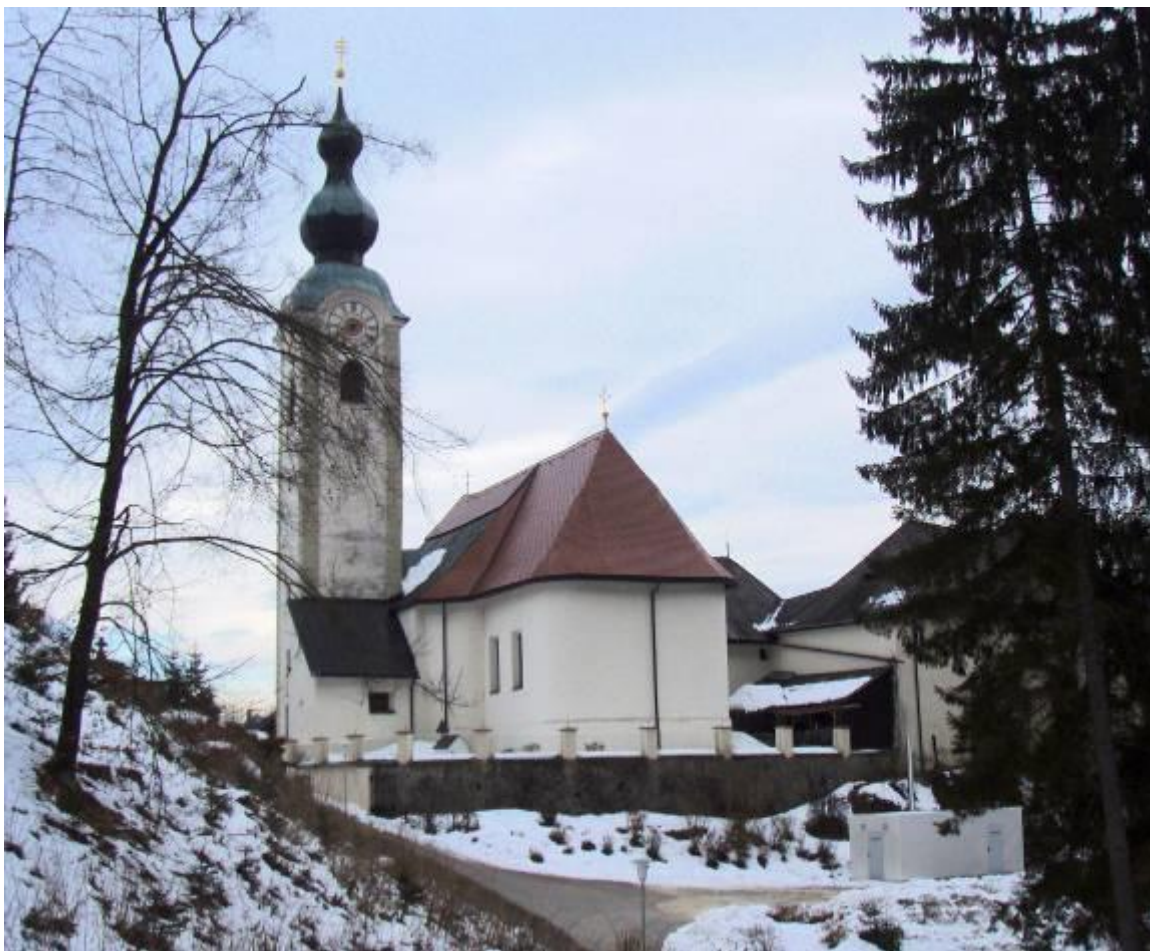
Obr. 4 Kostel Klagenfurt - jednoduchý kontejner + kotel na pelety (35kW)
