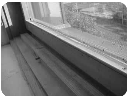
Obr. 2 – Detail zevnitř otevřeného okenního výkluzu zjednodušené konstrukce bez drátěné výztuhy dolního okraje sítky (foto Přidal).
